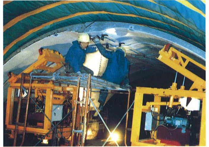
●PCL版据付状況
