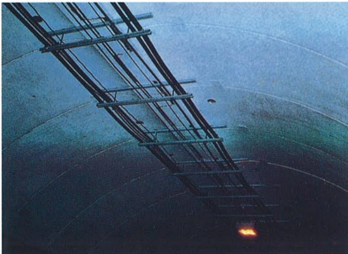
●据付完成状況
