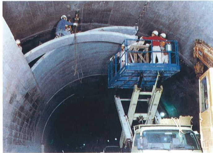
● PCL版据付状況
