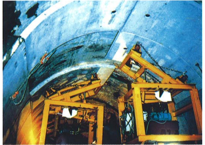
● PCL版据付状況
