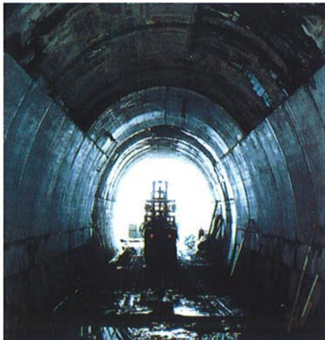
● 据付完了状況
