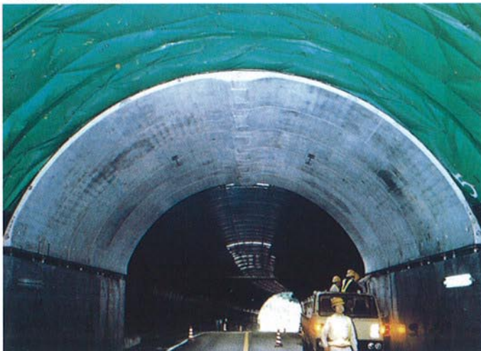
●据付完了状況
