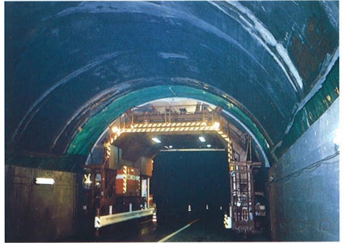
●PCL版据付作業
