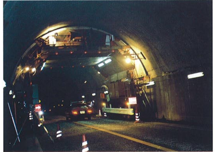
● PCL版据付状況
