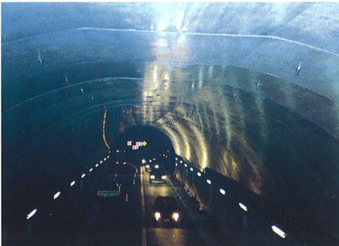
● 据付完成状況
