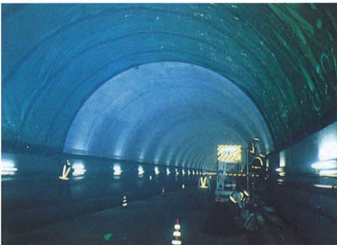
● 据付完了状況
