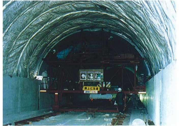
● PCL版据付状況
