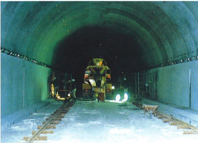
● 据付完了状況
