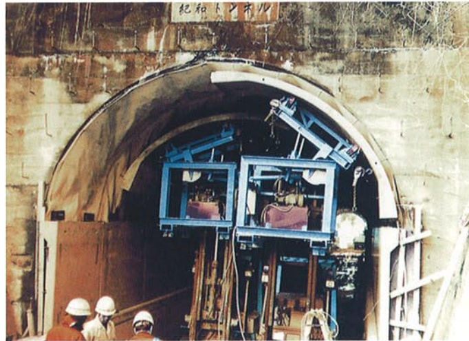
● PCL版据付状況
