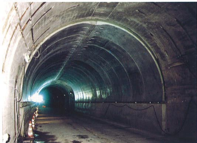
● 据付完了状況
