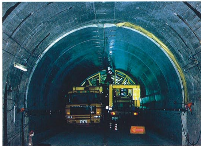
● PCL版据付状況
