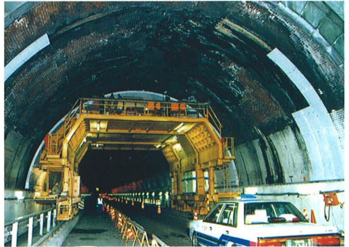
● PCL版据付状況
