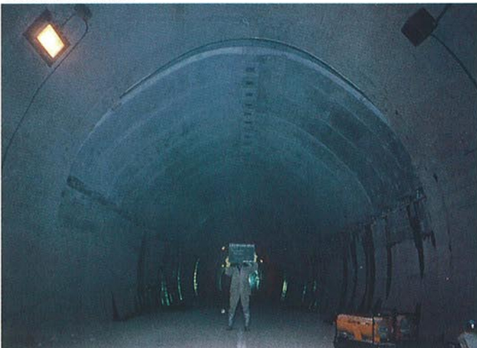
● 据付完成状況
