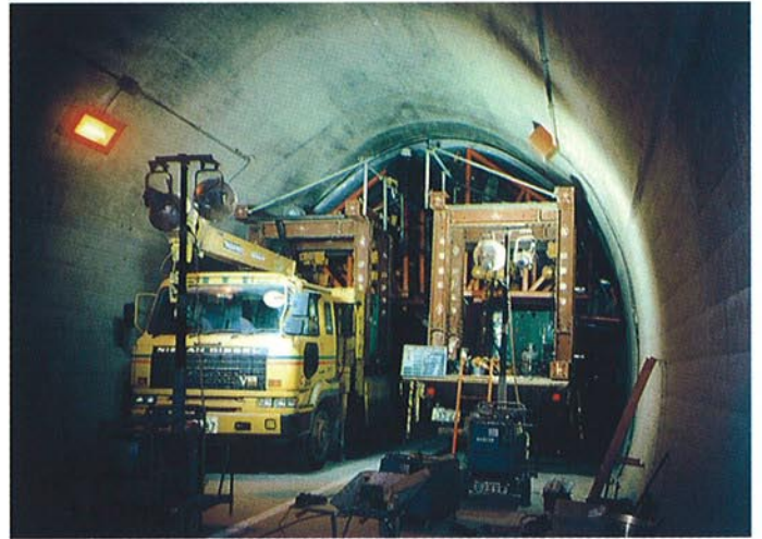
● PCL版据付状況
