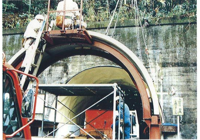
● PCL版据付状況
