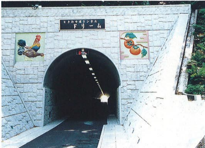
● 据付完成状況
