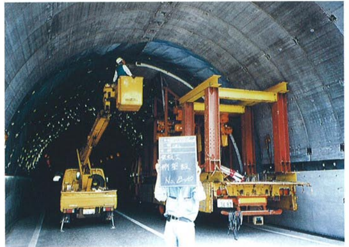
● PCL版据付状況
