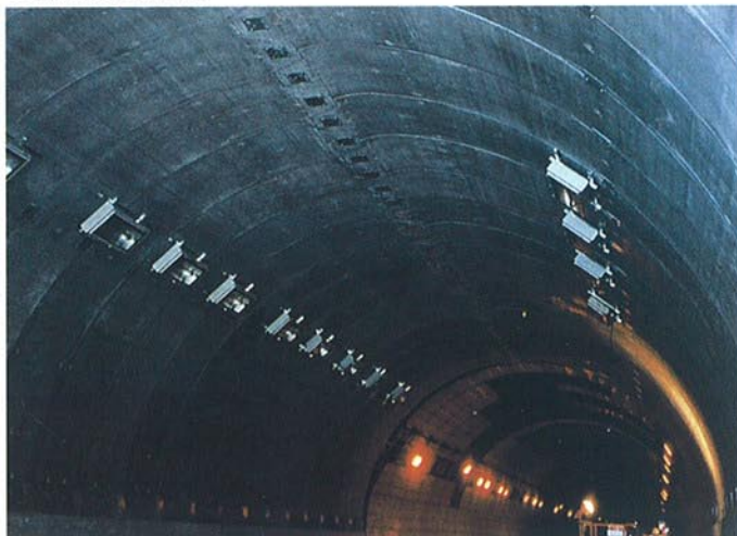
● 据付完成状況
