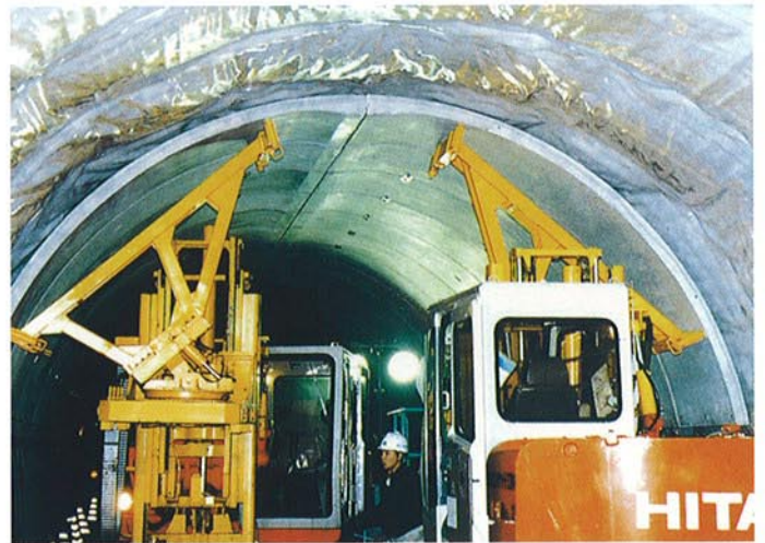
● PCL版据付状況
