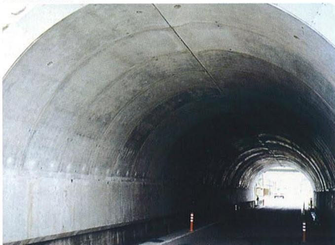
● 据付完成状況
