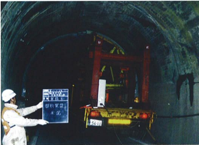
●PCL版据付状況
