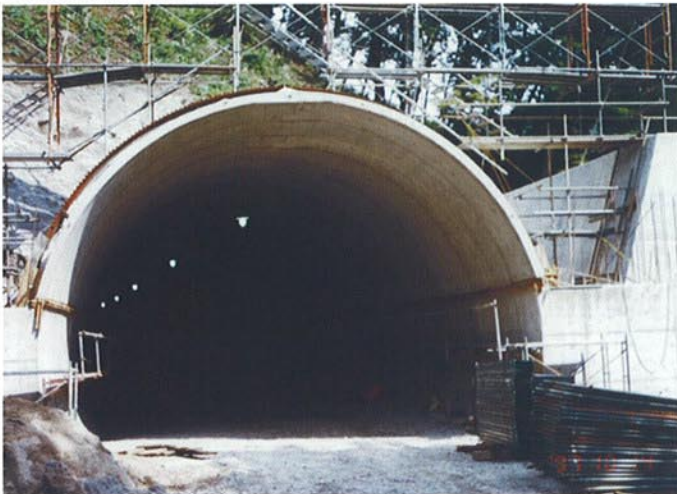
●据付完了状況
