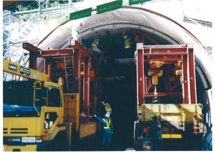
●PCL版据付状況
