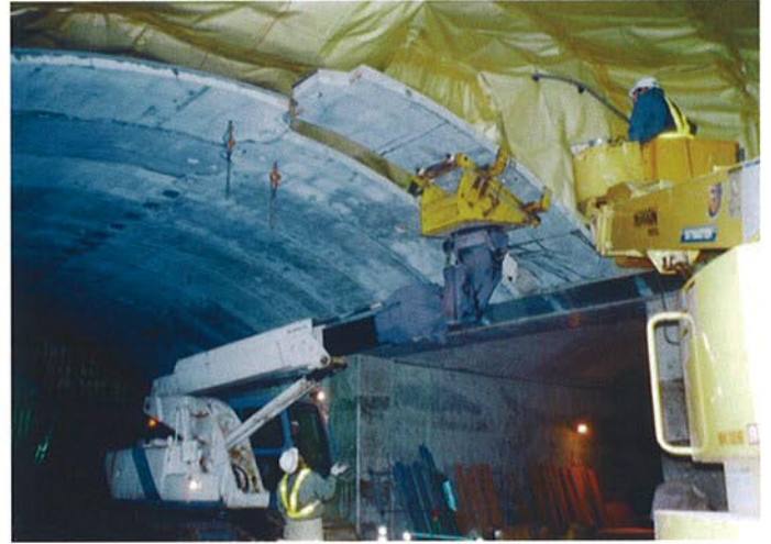
●PCL版据付状況
