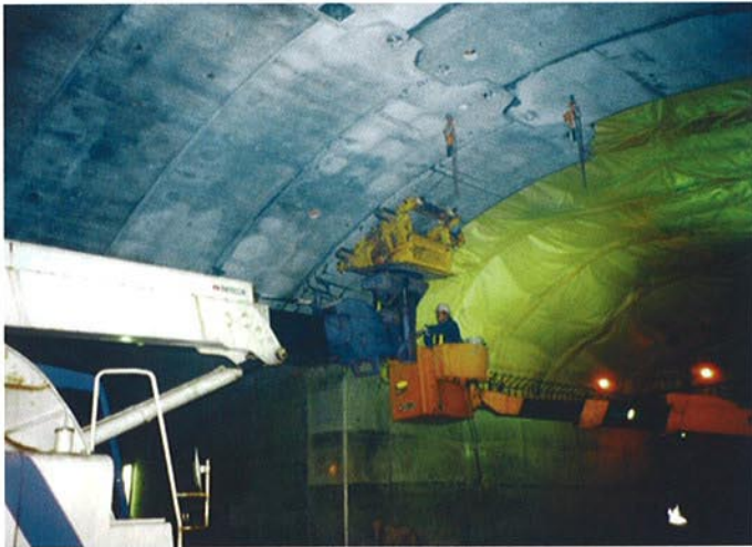
●PCL版据付状況
