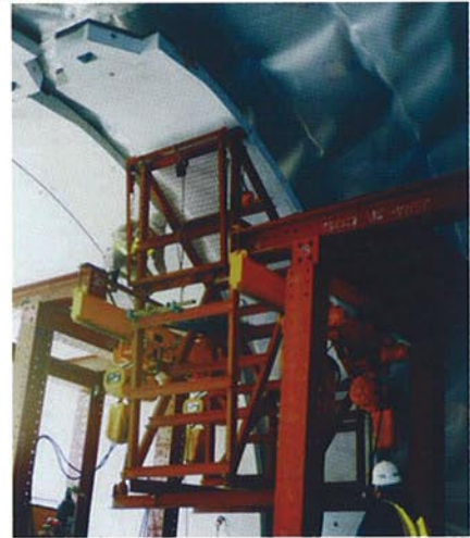
●PCL版据付状況
