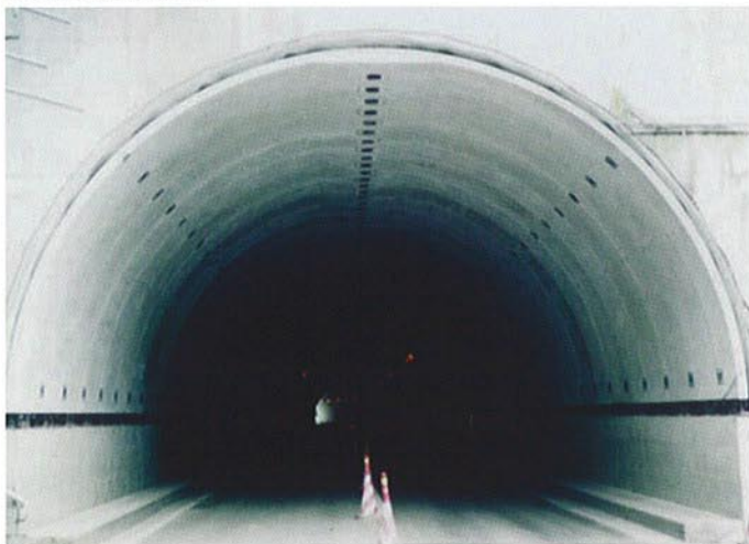
●据付完了状況
