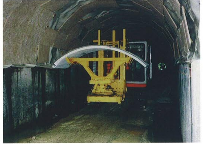
●PCL版据付状況
