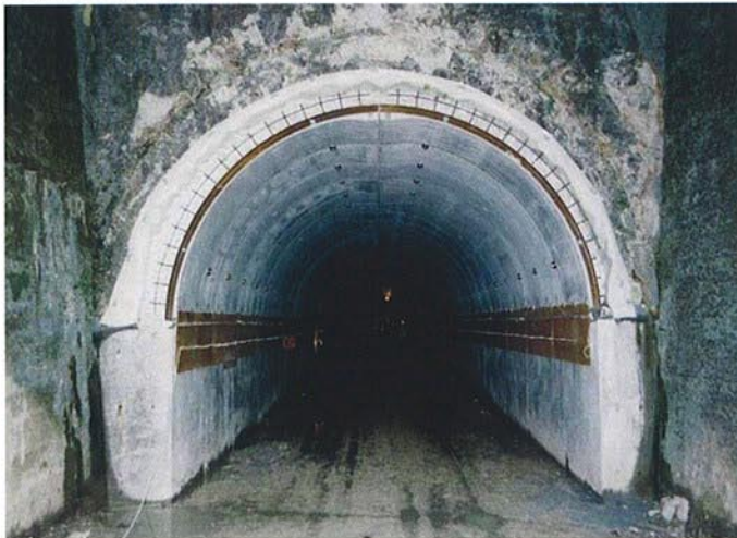
●据付完了状況
