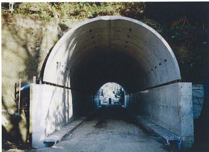
●据付完了状況
