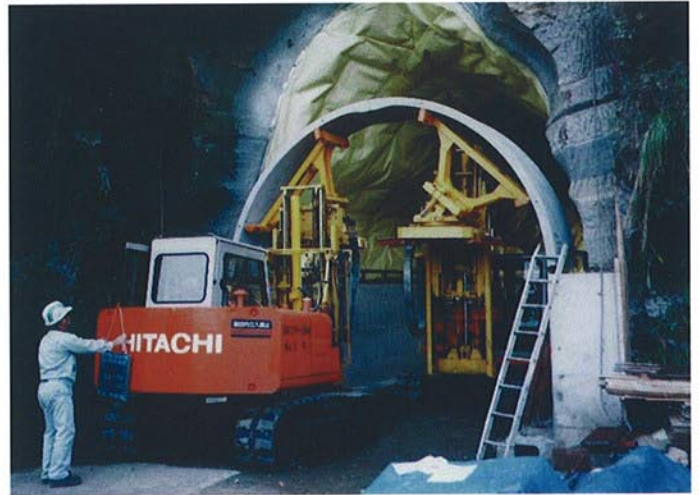
●PCL版据付状況
