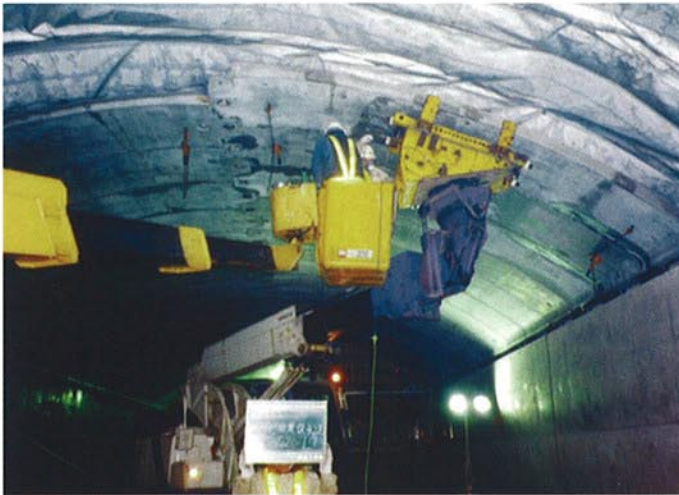
● PCL版据付状況
