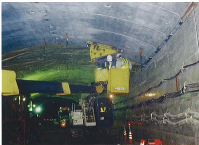
●PCL版据付状況
