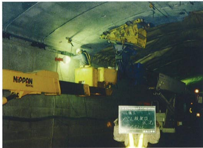
●PCL版据付状況
