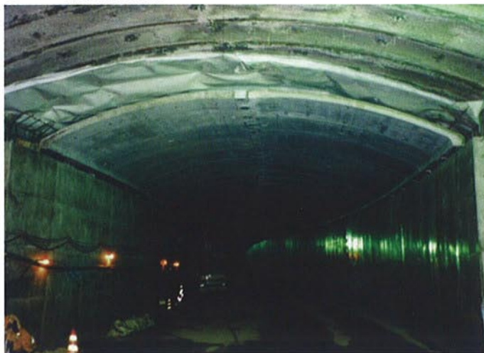
●PCL版据付状況
