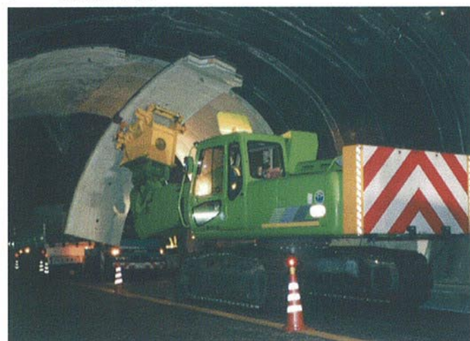
● PCL版据付状況
