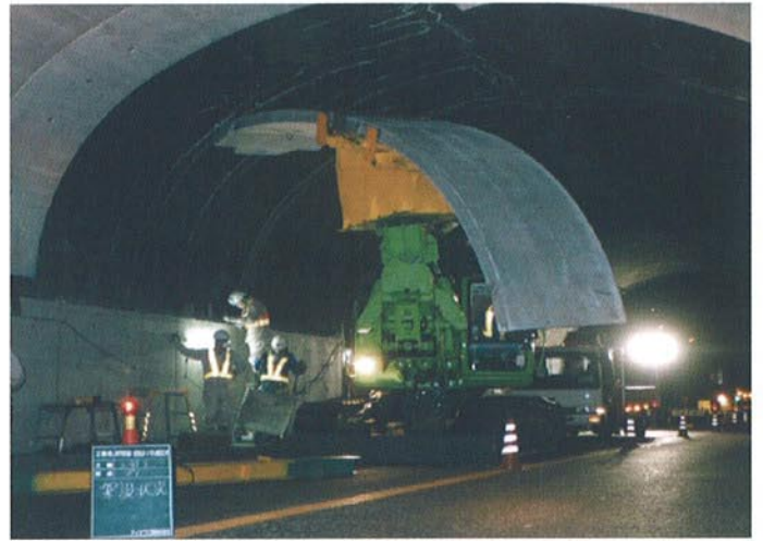
● PCL版据付状況
