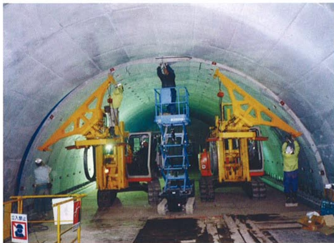
● PCL版据付状況
