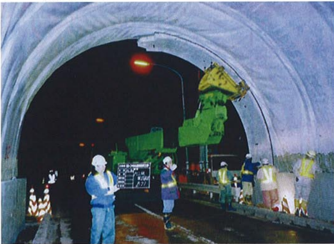
● PCL版据付状況
