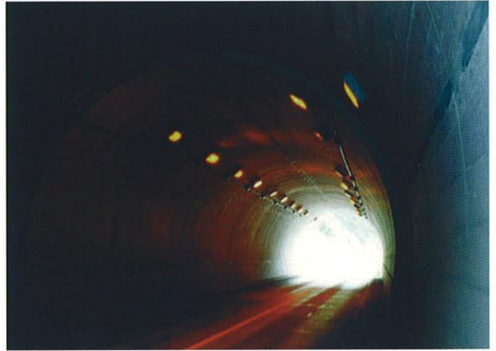
● 据付完了状況
