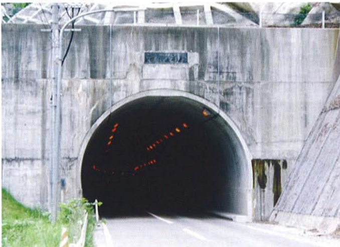
● 据付完了状況
