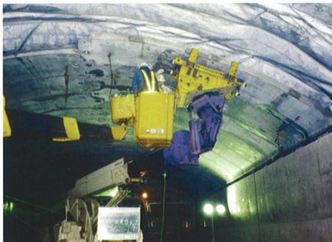
●PCL版据付状況
