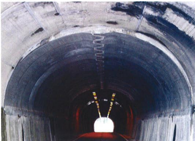
● 据付完了状況
