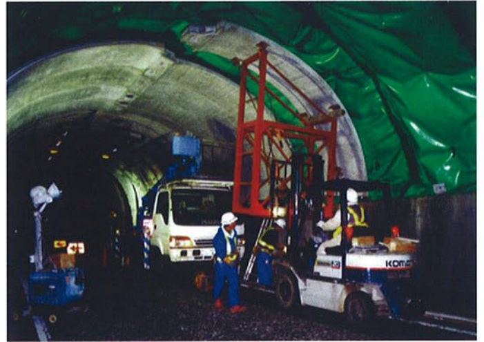
● PCL版据付状況
