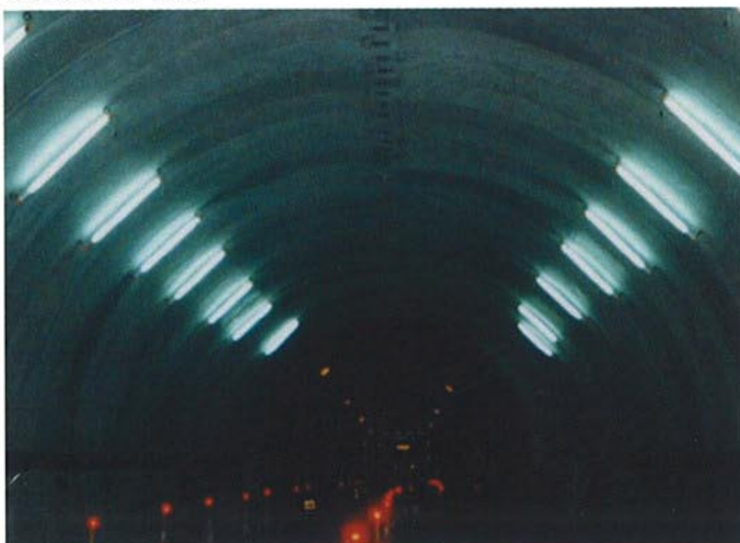
●据付完了状況
