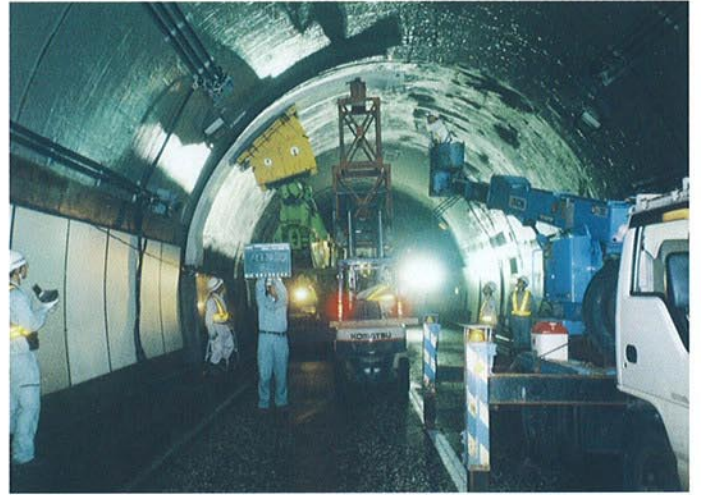
● PCL版据付状況
