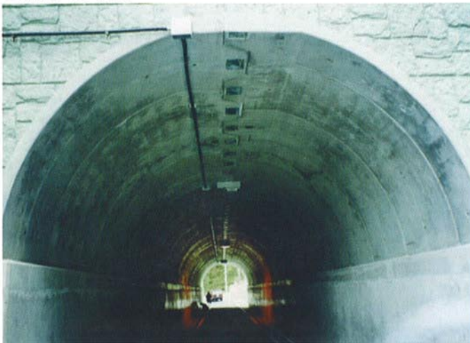
●据付完了状況
