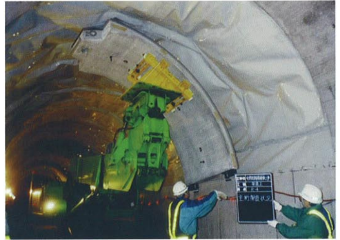
●PCL版据付状況
