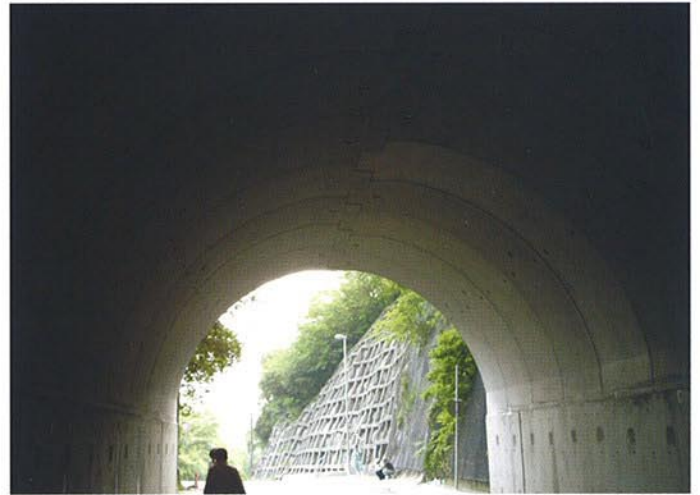
●据付完了状況
