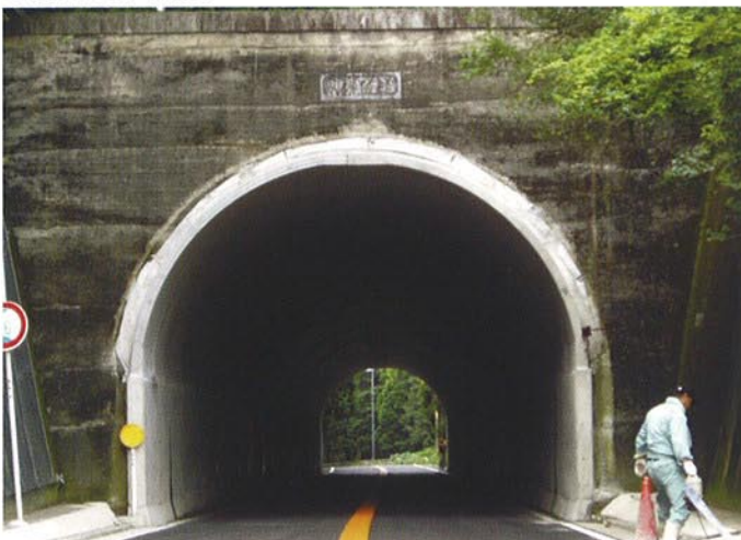
●据付完了状況
