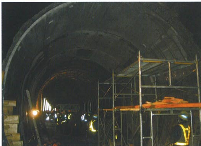
●据付完了状況
