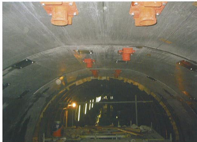
●PCL版据付状況
