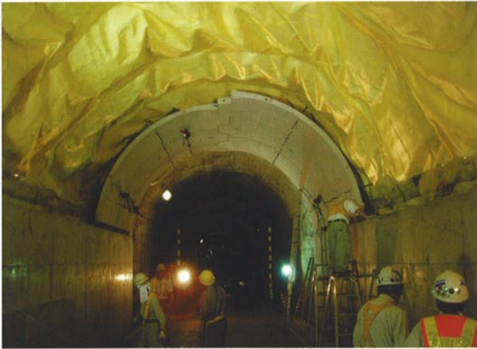
●PCL版据付状況
