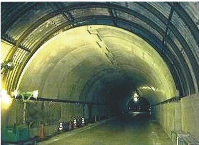
●据付完了状況
