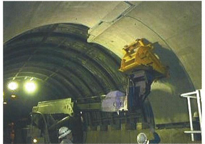
●PCL版据付状況
