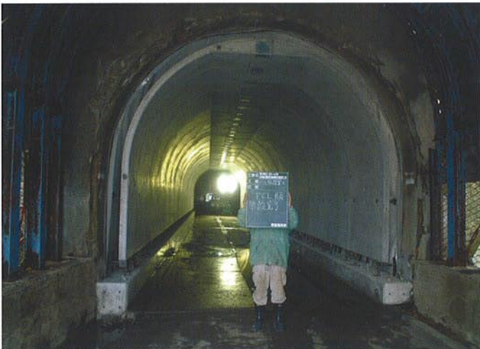
●据付完了状況
