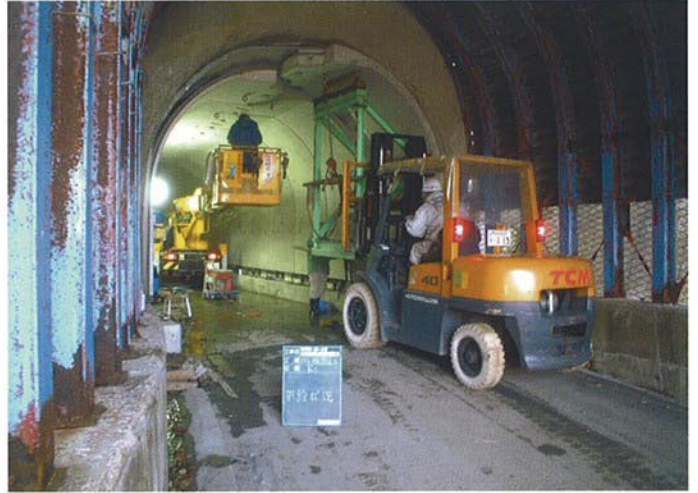
●PCL版据付状況
