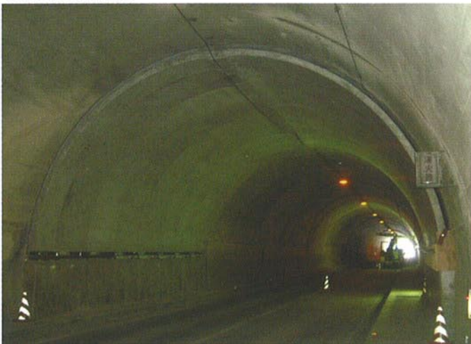
● 据付完了状況
