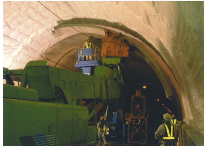
● PCL版据付状況
