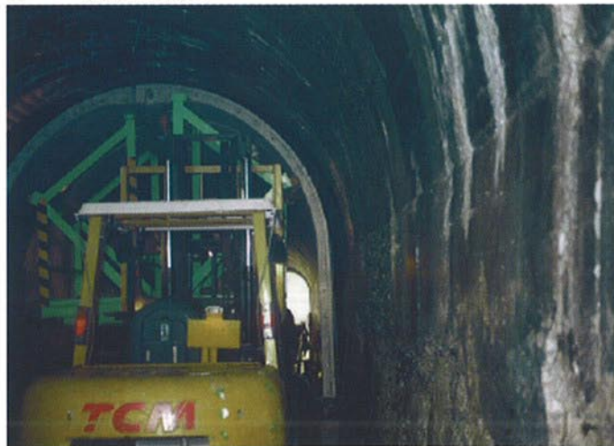
●PCL版据付状況
