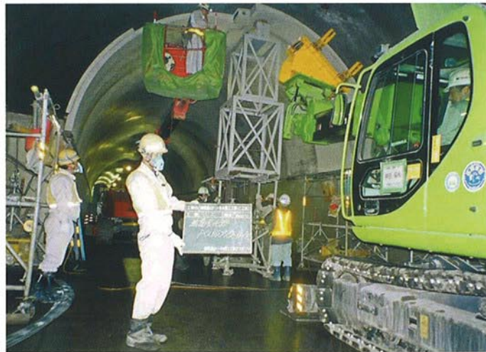
● PCL版据付状況
