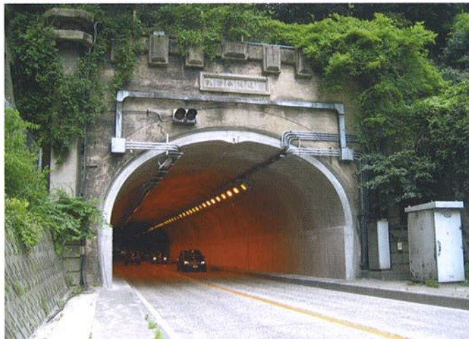
● 据付完了状況
