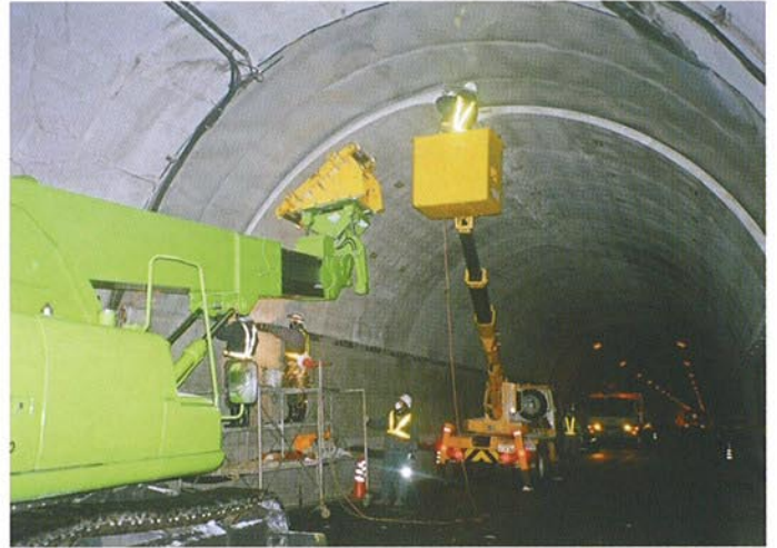
● PCL版据付状況
