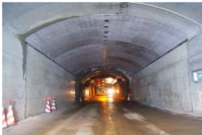
● 据付完成状況
