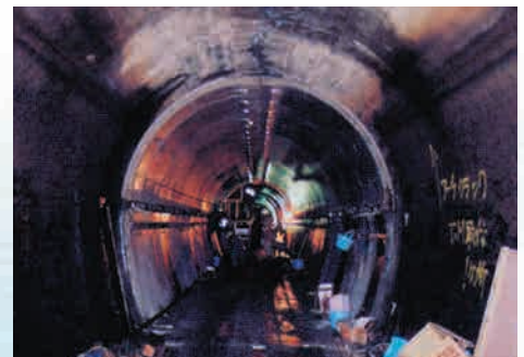
水路 (補修・補強)
