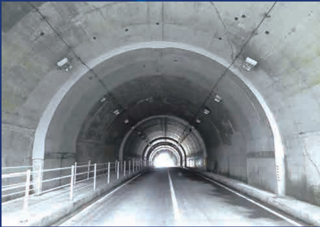
□ 補強事例 (下浦トンネル: 大分県)
