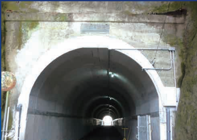
□ 補修事例 (川津南トンネル: 千葉県)
