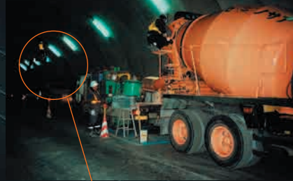
裏込め注入工
