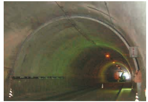
道路 (補修・補強)
